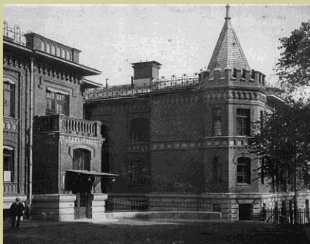
Здание клиники Института питания в 1941-1945 гг.
